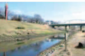
陸送ルートに代わり、水運で利根川と江戸川を結ぶために明治23年に完成した利根運河
